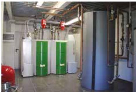
Installation de chaudière en cascade dans le collectif
